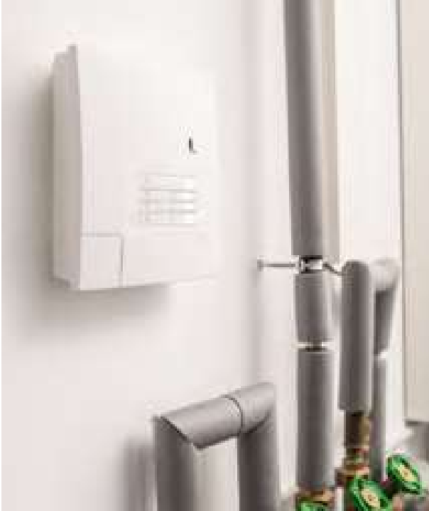
↗ Zentrale einer Alarmanlage im Haustechnikraum
