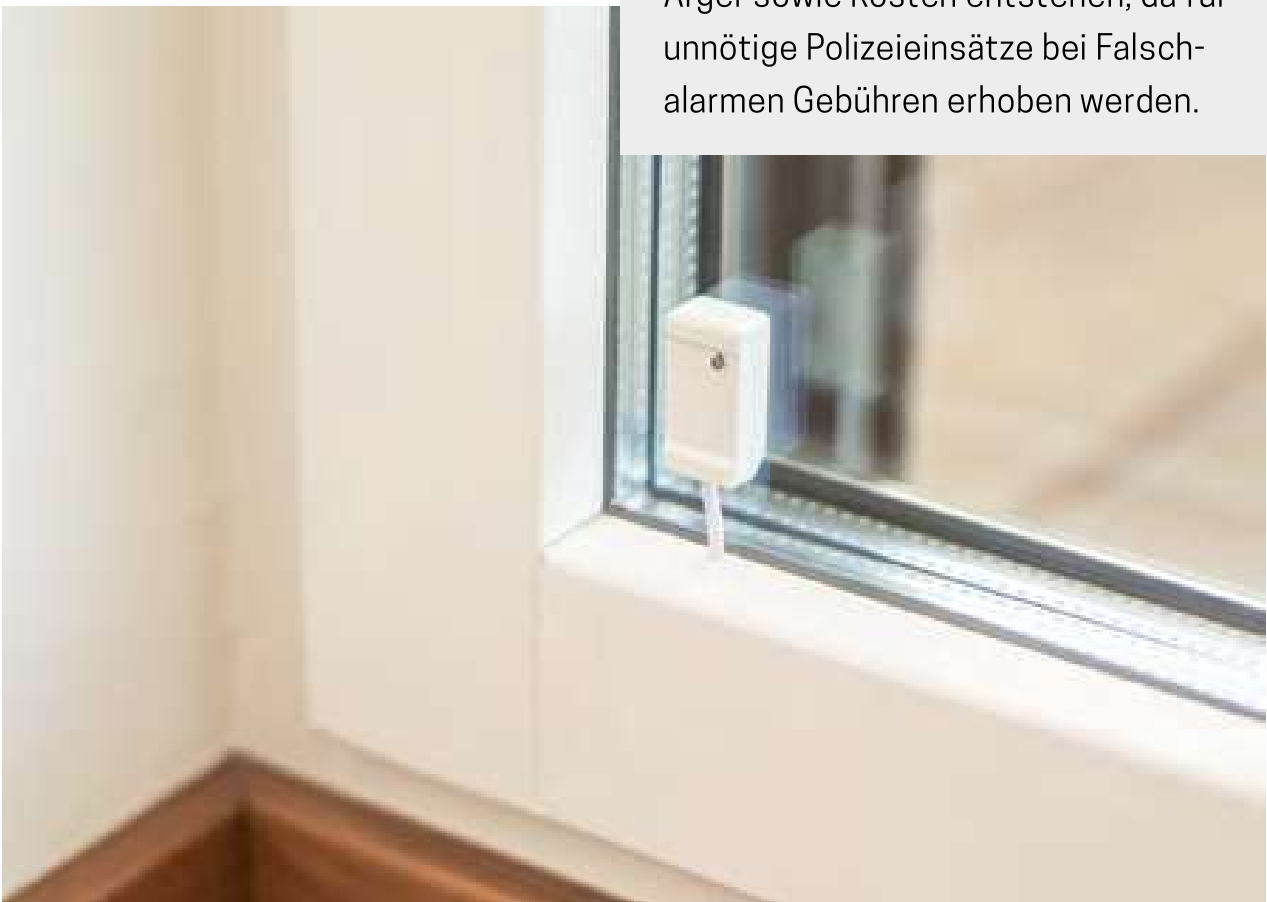
↗ Außenhautüberwachung mit einem Glasbruchmelder
